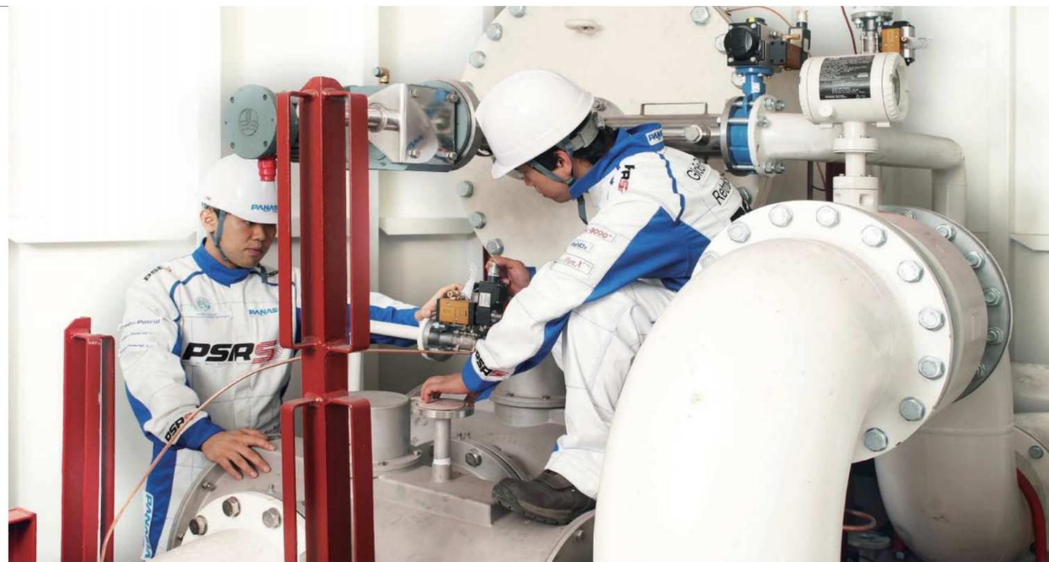
米国の独自規制とIMO批准の到来により、既存船への設置義務が迫っています。既存船という制限された場所や時間内に装置を設置するためには多様な工夫が必要とされます。
